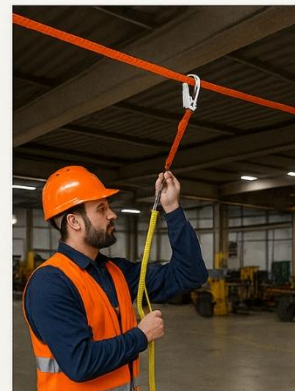
2 Conectar una línea de vida al anclaje
